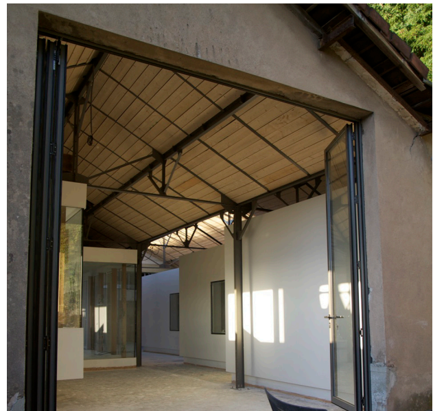
Ci-dessus: vue depuis le jardin suspendu (@Ludmila Cerveny); maquette du projet (@Bagard-Luron); vues du chantier en cours de construction
