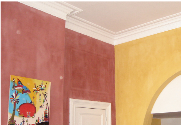
Isolation par l'intérieur et isolation des murs de refend sur 1m Finitions: enduit à base d'argile, mur en briques peint, finition plâtre naturel sur le mur de refend, peintures naturelles. Ci-contre: façade arrière et extension en bois ©Espace Environnement asbl
