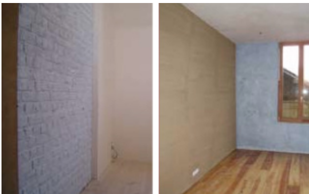
Isolation par l'intérieur et isolation des murs de refend sur 1m Finitions: enduit à base d'argile, mur en briques peint, finition plâtre naturel sur le mur de refend, peintures naturelles. Ci-contre: façade arrière et extension en bois ©Espace Environnement asbl
