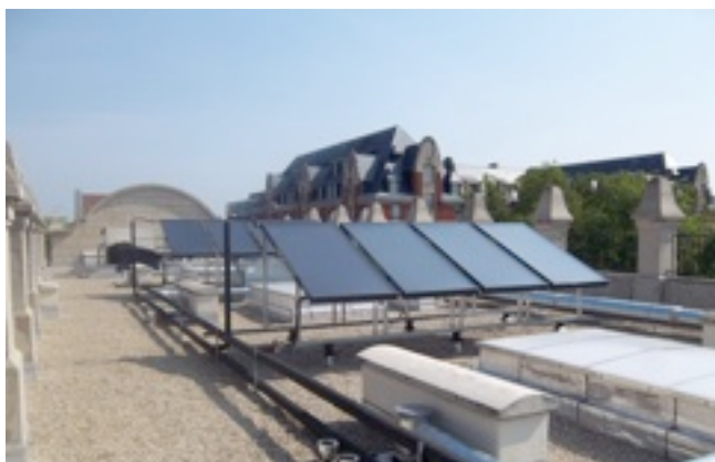
Des panneaux solaires ont été placés sur la toiture
