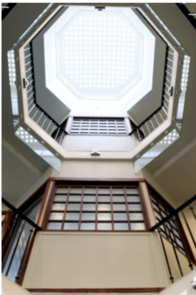
Le bâtiment bénéficie d'un apport de lumière naturelle par l'intermédiaire de ce puits de lumière
