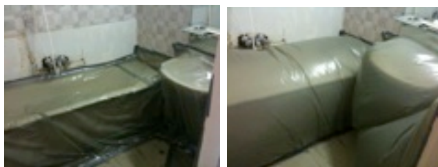
La mise en dépression du bâtiment a permis de peaufiner les détails d'étanchéité à l'air. Ci-dessus, l'opération réalisée dans une salle de bain : à gauche, pas de mise en dépression, à droite, mise en dépression
