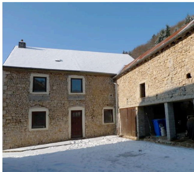
Ci-dessus: bâtiment après restauration côté rue et ci-contre: bâtiment avant rénovation côté cour
