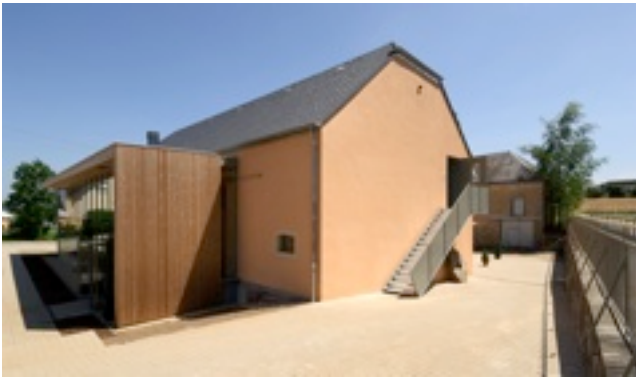
L'ancienne grange du moulin a été restaurée en un centre de rencontres et séminaires...
