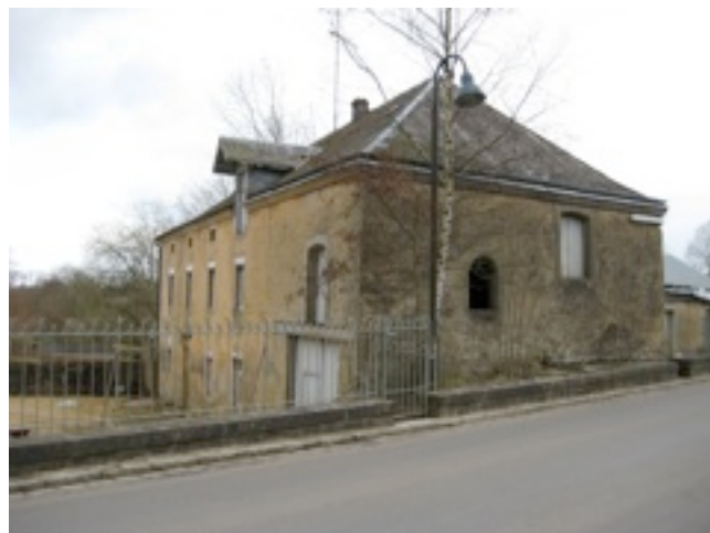
Le moulin proprement dit avant rénovation
