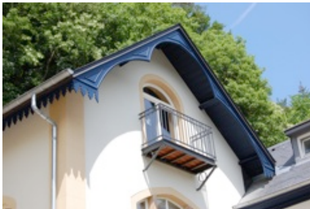
Détail du bord de toiture
