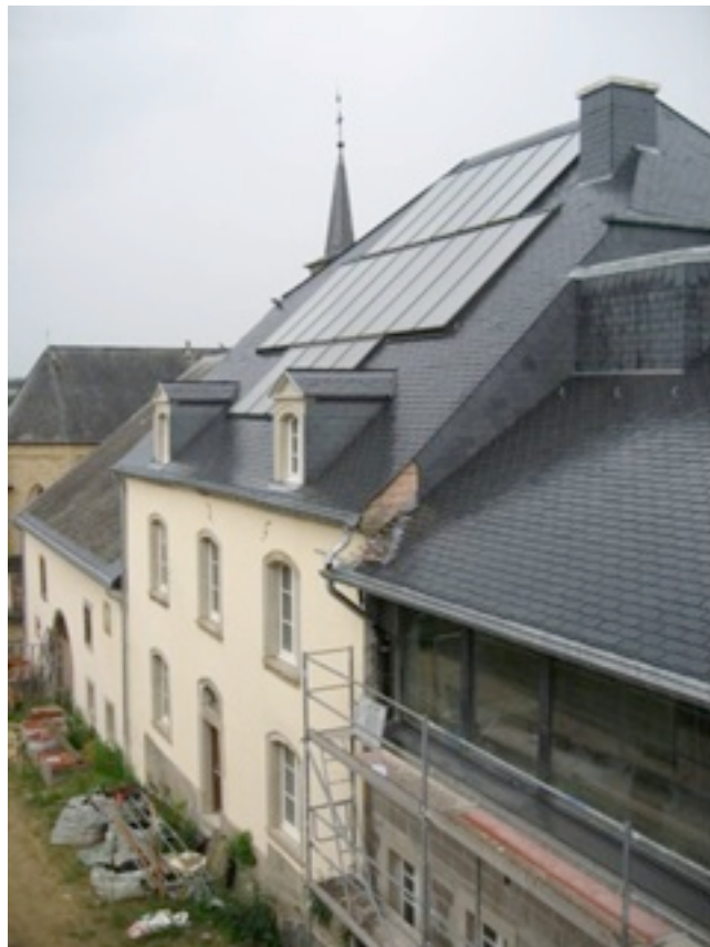
L'intégration des capteurs solaires a été travaillée de manière à en diminuer l'impact. Ces capteurs servent à l'eau chaude sanitaire, au chauffage du sol en mi-saison et au chauffage mural, mais aussi à la recharge des collecteurs de sol et des forages géothermiques pendant l'été
