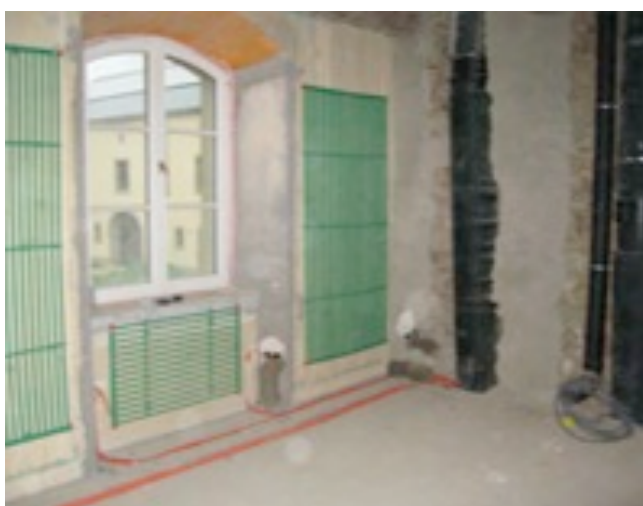
Là où le chauffage par le sol n'a pas été possible en raison de solives en bois trop hautes, des planchers en bois ou des voûtes, un chauffage mural a été installé
