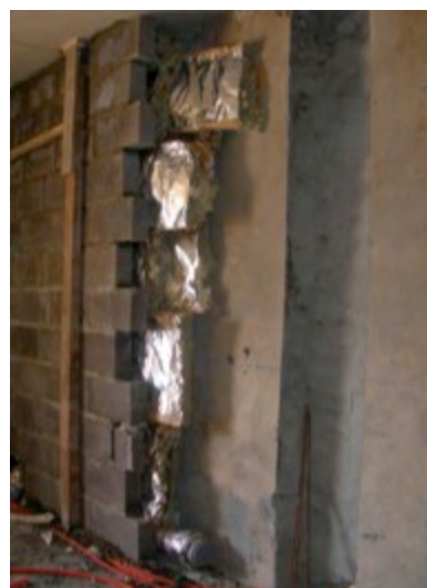
L'isolation des parois par l'intérieur a été rendue possible grâce à la dimension confortable des pièces. Les parois de la partie nouvellement construite sont isolées par l'extérieur pour éviter les ponts thermiques
