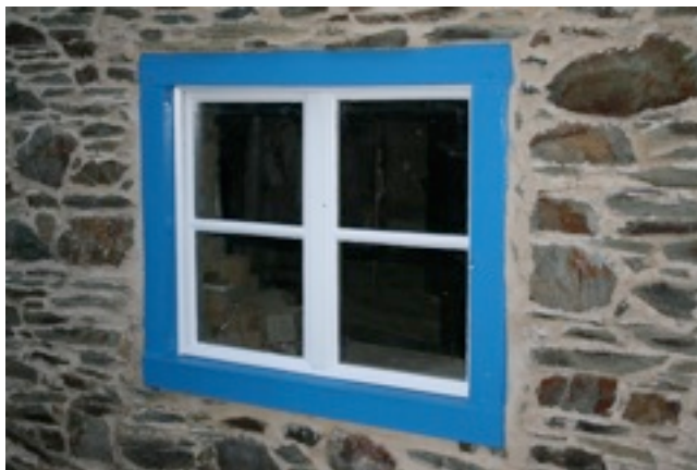
Une des fenêtres du pignon sud refaite à l'identique
