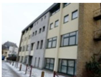
... et après rénovation
