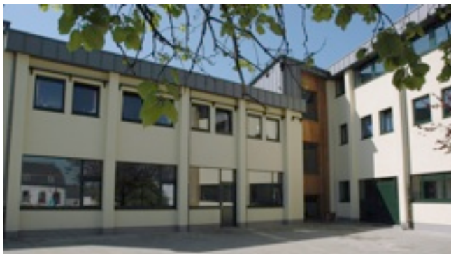
Vue depuis la cour après embellissement
