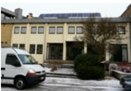
Des panneaux solaires ont été posés sur l'un des toits de l'établissement
