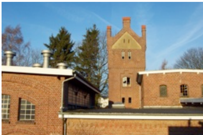
Vue sur l'arrière du bâtiment
