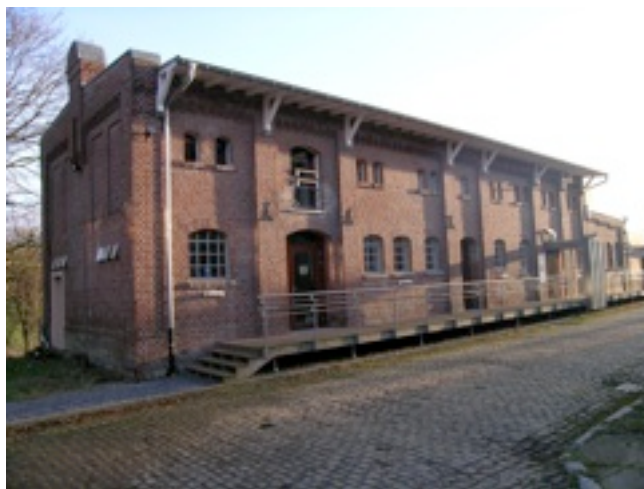
L'aspect extérieur a été préservé, l'isolation ayant été réalisée par l'intérieur
