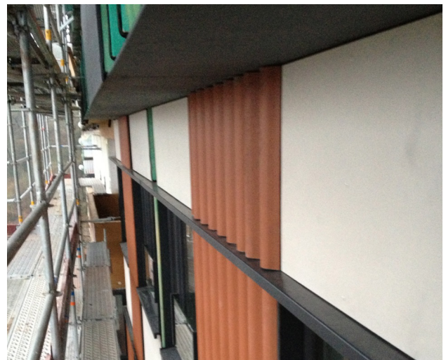
Ci-dessus et ci-contre: étapes de l'isolation des façades - structure en bois, pare-pluie en fibres de bois, cellulose soufflée et bardage en fibre de ciment ©awarchitectes
