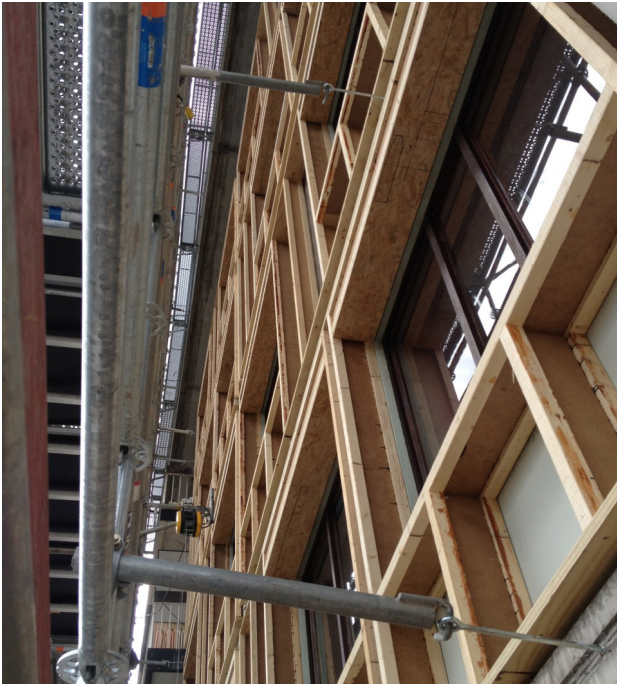
Ci-dessus et ci-contre: étapes de l'isolation des façades - structure en bois, pare-pluie en fibres de bois, cellulose soufflée et bardage en fibre de ciment ©awarchitectes
