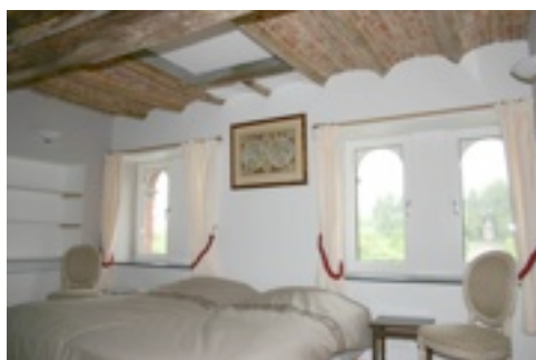
Voussettes restaurées et intégrées
