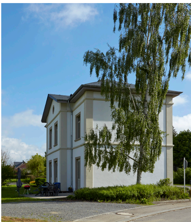
Ci-dessus: bâtiment rénové
