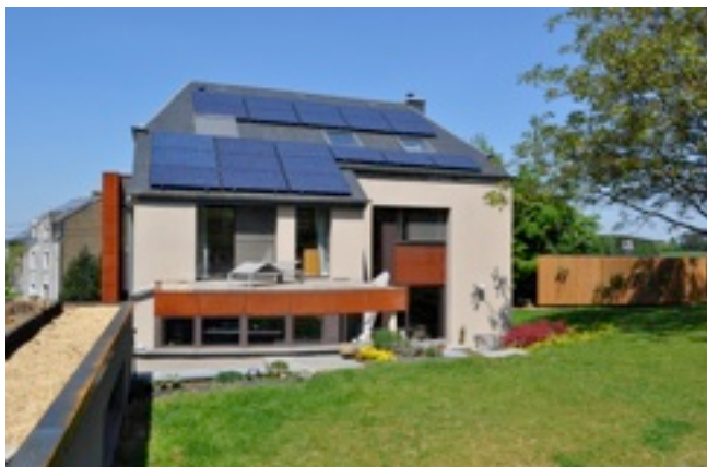
Vue arrière du bâtiment
