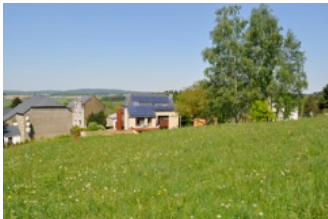
Le propriétaire a exploité l'orientation au sud de la pente arrière du toit pour y placer des panneaux photovoltaïques
