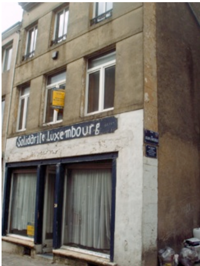
A l'abandon depuis de nombreuses années, le bâtiment se trouvait dans un état de conservation peu satisfaisant...
