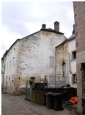
Vue du bâtiment avant rénovation
