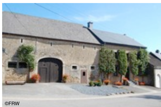
Une ferme à Tontelange (B)
