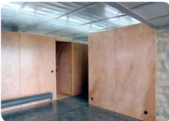
Modules en bois pour les chambres à coucher et les services glissés sous la coque en aluminium qui est visible de chaque pièce. Modules isolés pour un meilleur confort des occupants.
