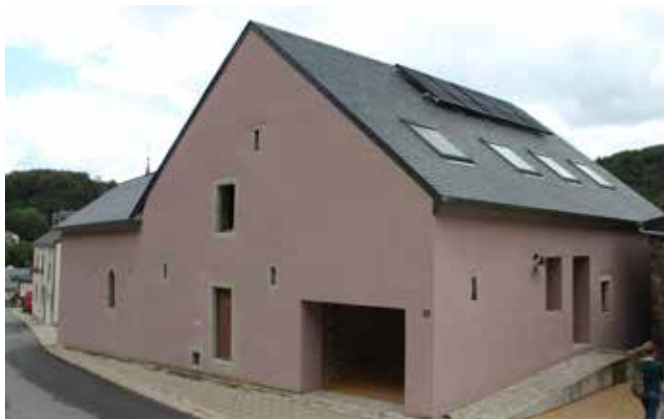
Ferme transformée en logements performants en énergie à Septfontaines (GDL)
