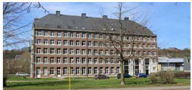
Maison Pelzer, patrimoine industriel transformé en logements, à Verviers (Wallonie)
